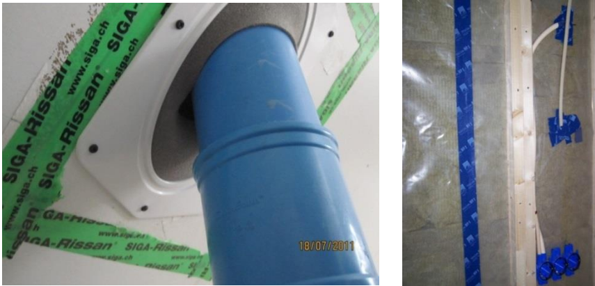
Figuur 5: Maatregelen luchtdichtheid niveau Passief Bouwen
