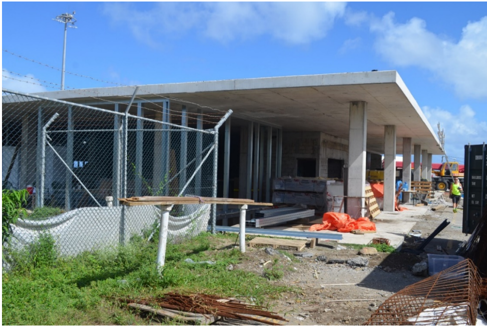
De bouw van de nieuwe luchthaven
