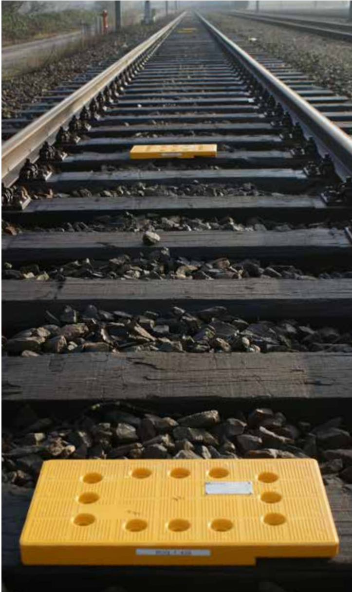
Eurobalises in de railinfrastructuur
