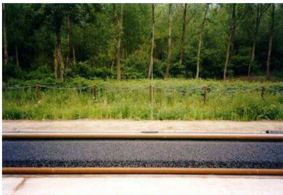
Figuur 5.2 Absorberend asfalt tussen de rails
