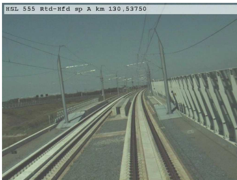
Figuur 6.6 Geluidsmaatregelen Hoogmade (km 30,7) alleen schermen aan de oostzijde. Spoorbaan ligt 7 m boven het maaiveld (afkomstig uit referentie 7).
