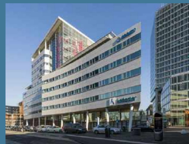
Beperkte kwaliteit van enkele plinten (huidig)
