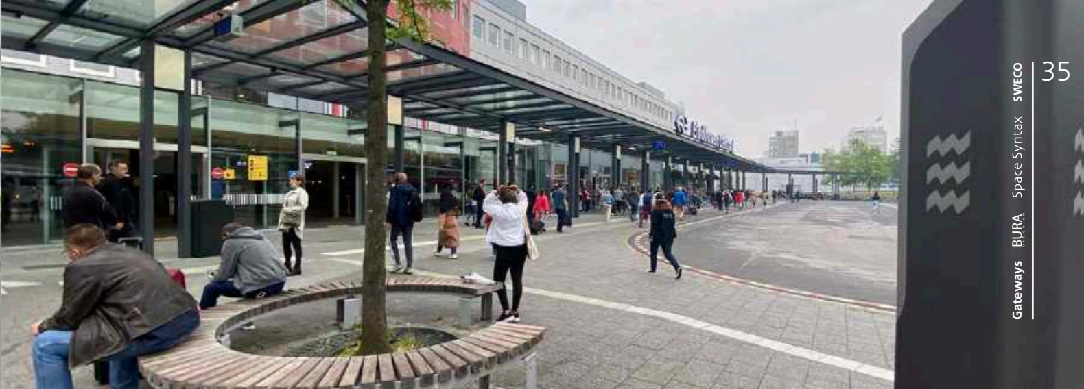
10. Gebouw Noordzicht met wachtruimte
