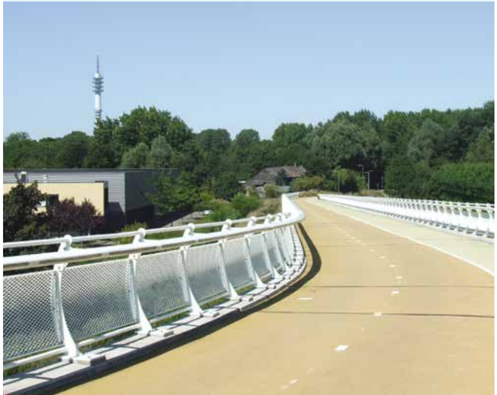
De noordelijke aanbrug (afrif) van de Groene Verbinding. (BRON: BART BEEN, DCMR)
