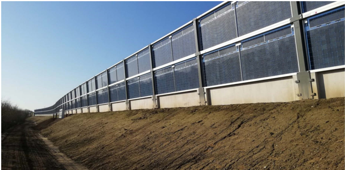
Figuur 5 Bifaciale panelen langs de A50 bij Uden, geluidswal en zonne-energie gecombineerd. Foto: Solar Energy Application Centre (Bron: PV Magazine 20/2/2019).
