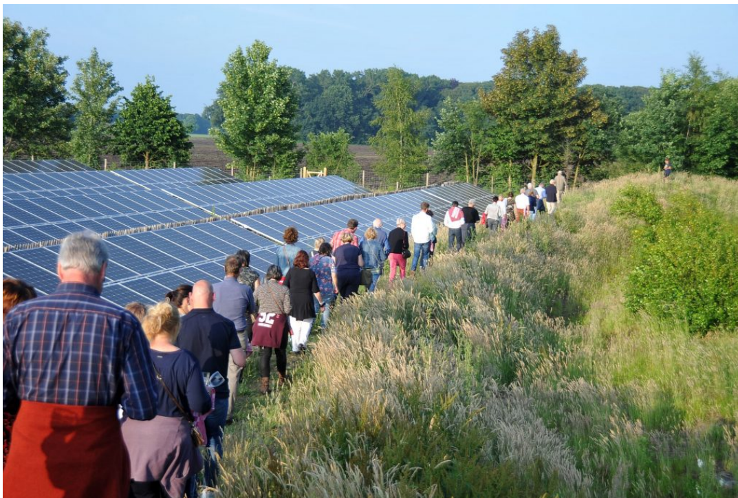
Figuur 27 Solarpark De Kwekerij (bron: https://nlsolarparkdekwekerij.nl ).
