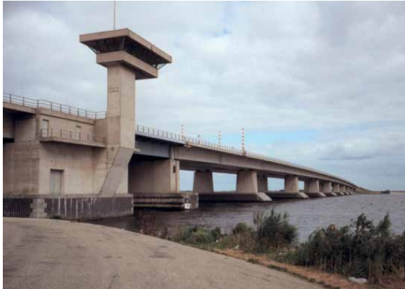
Figuur 1: De Ketelbrug
