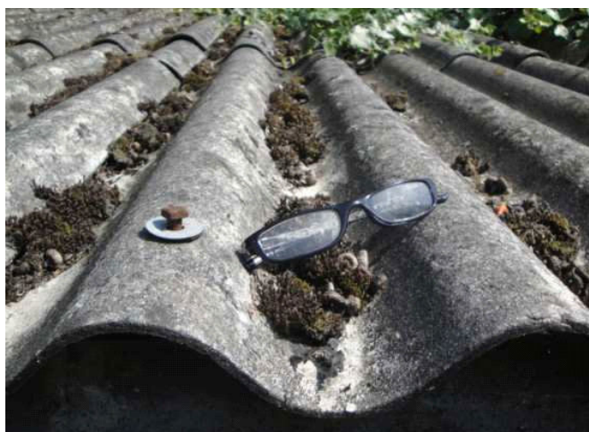
Figuur 5-1: Een golfplaten dak van asbestcement in Lisse.
