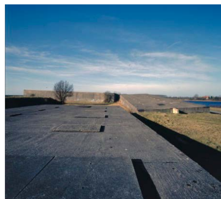
De watersnoodramp in 1953 is nog tastbaar in de buurt van Ouwerkerk, waar een gat in de dijk werd gedicht door vier betonnen caissons af te zinken. In de vier caissons is nu het watersnoodmuseum gevestigd. Foto's: Joop van Houdt en RCE/G.J. Dukker
