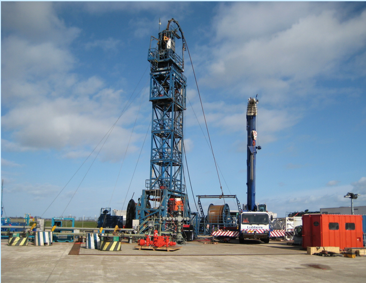
De coiled tubing installatie op locatie voor de workover (Foto SodM)
