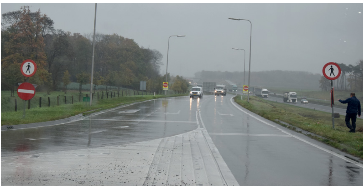
Figuur 11: Afrit 22 'Maasbracht' van de A73, waarbij een bord 'verboden in te rijden' is weggedraaid (Bron: VOA Politie Limburg).
