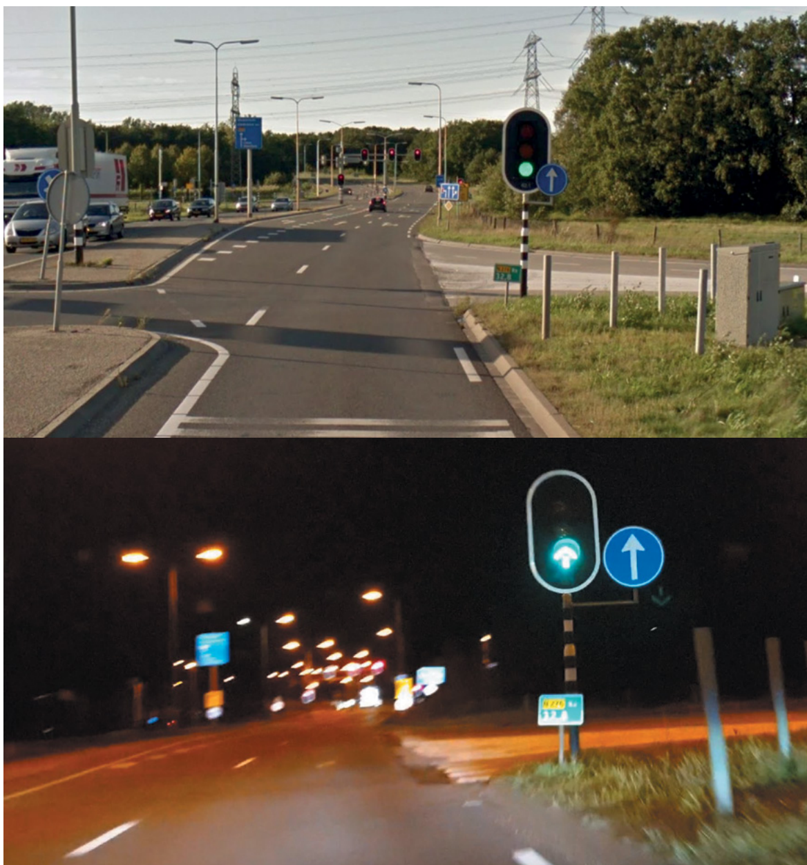
Figuur 9: Wie bij dit verkeerslicht rechts afslaat, rijdt de afrit op. De bovenste foto is de situatie ten tijde van het ongeval, de onderste foto is de aangepaste situatie (Bron: bovenste foto Google Street View, opnamedatum september 2015. Foto onder eigen opname uit 2019).
