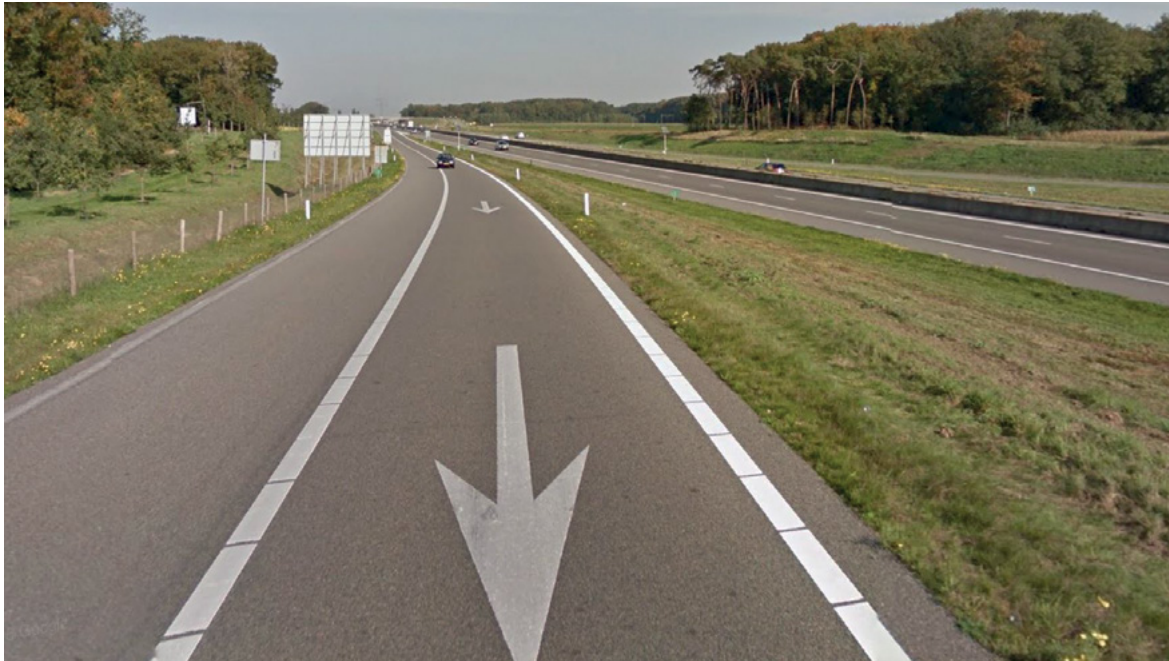
Figuur 12: Pijlen op de weg geven de juiste rijrichting aan. Wie de pijlen niet waarneemt, kan de indruk krijgen op de rechterraijstrook van een tweerichtingsweg te rijden (Bron: Google Street View, opnamedatum: september 2018).
