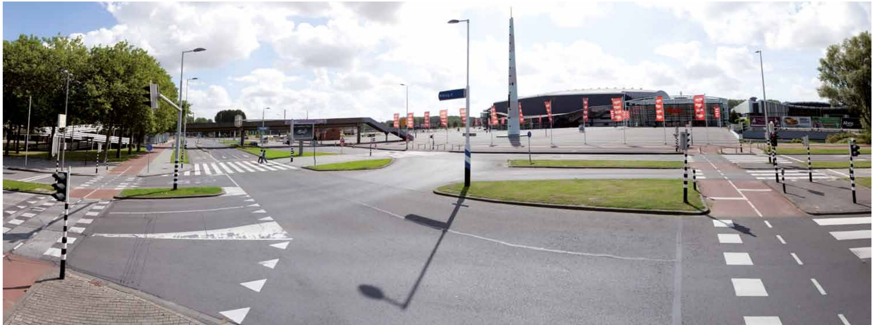
Outside view of Ahoy / Vue de l'extérieur d'Ahoy
