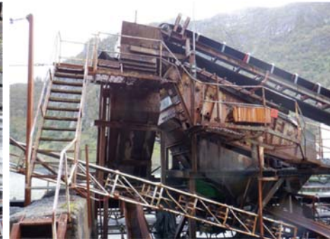
Eikefet: 2 wassers, nadere inspectie niet mogelijk
