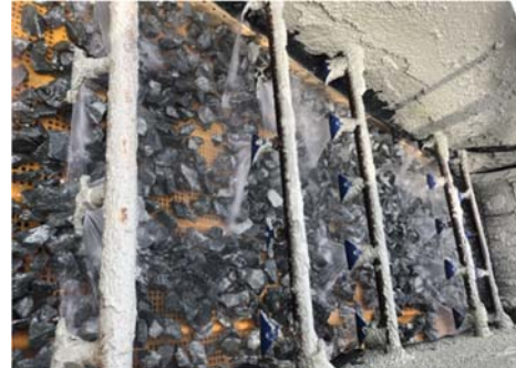
Amsterdam (Bremanger/Glensanda): 1 wasser met 5 buizen x 5 sproeiers
