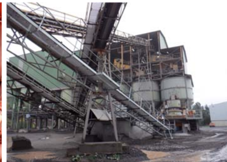
Werk-Nickenich: installatie, nadere inspectie niet mogelijk
