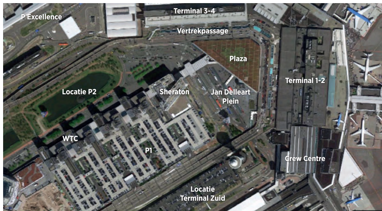
Figuur 1. Locatie Multimodale Knoop Schiphol (Plaza en Jan Dellaertplein)
