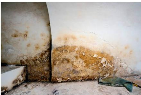
Optrekkend en doorslaand vocht
