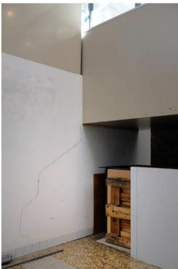
Scheurvorming
