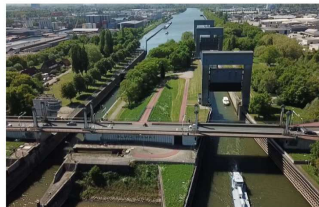
Figuur 9. Foto van Sluis Weurt (links de oude Oostkolck en rechts de Westkolck)
