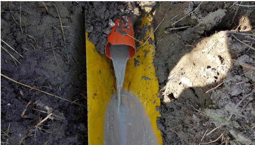
Fig. 3.8 Klei- slibresten uit drain na spoelen
