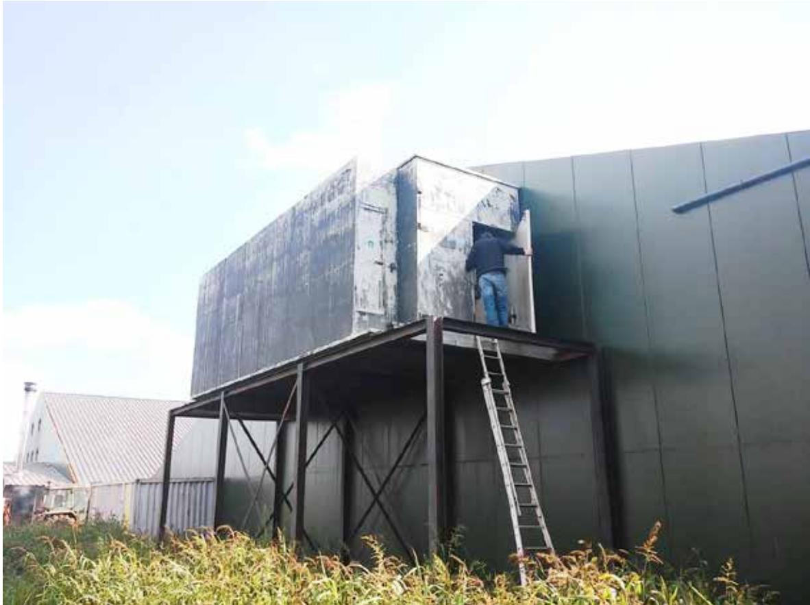
Figuur 7 Luchtwasser alleen te bereiken met schuifladder.
