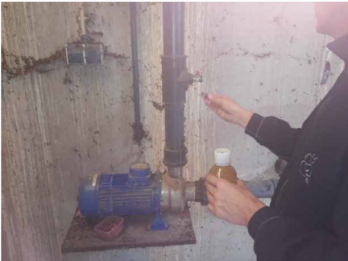
Figuur 2 Monstername van recirculatieleiding waswater.
