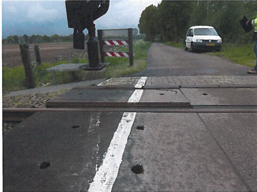
Figuur 14. Ongelijke ligging overwegvloerplaat te Gelre
