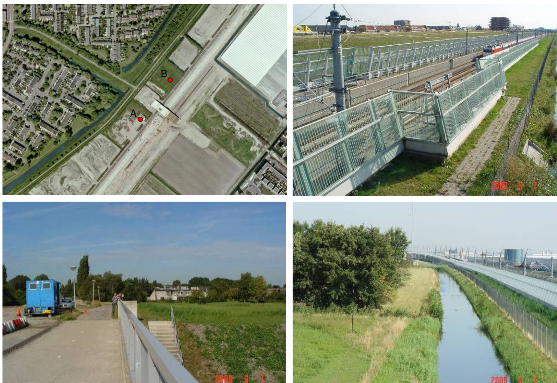
Figuur 2.2: Foto's van de locatie voor trillingsmetingen ter hoogte van Berkel en Rodenrijs, met rechtsboven de nooduitgang van het spoor, kijkend richting het zuiden vanaf het viaduct van de Offenbachlaan (foto links onder), dat op de luchtfoto net als de tunnelbak nog in aanbouw is. De twee meetposities A en B (rode punten op de luchtfoto links boven) liggen op 25 meter afstand tot het spoor voor de richting Rotterdam (meethoogte 3,5 meter ten opzichte van het maaiveld). De foto rechtsonder toont het uitzicht richting noorden, waar de verdiepte ligging overgaat in een verhoogde ligging.
