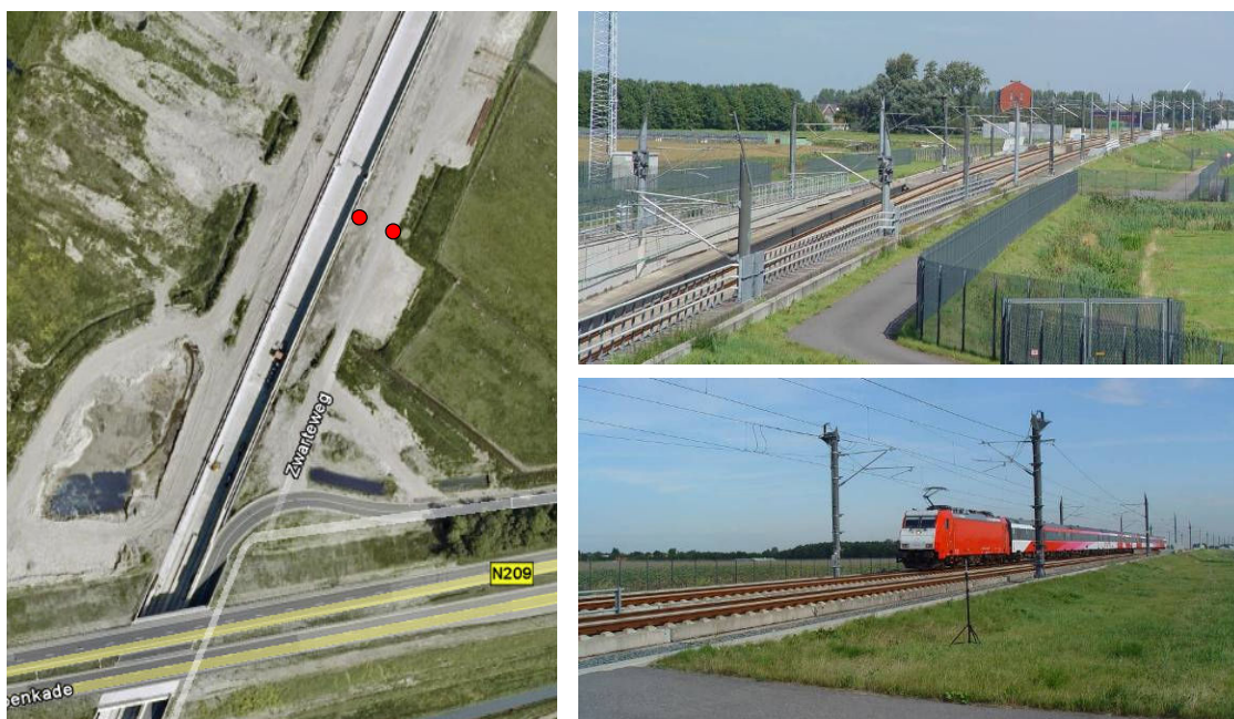
Figuur 2.1: Foto's van de referentielocatie voor geluid- en trillingsmetingen in Schiebroek. De foto links is een luchtfoto in de situatie toen het spoor nog in aanbouw was. De rode punten in deze foto zijn de posities van de microfoons op 7,5 meter en 20 meter afstand tot het spoor voor de richting Amsterdam (meethoogten respectievelijk 1,2 meter en 3,5 meter ten opzichte van spoorhoogte).
