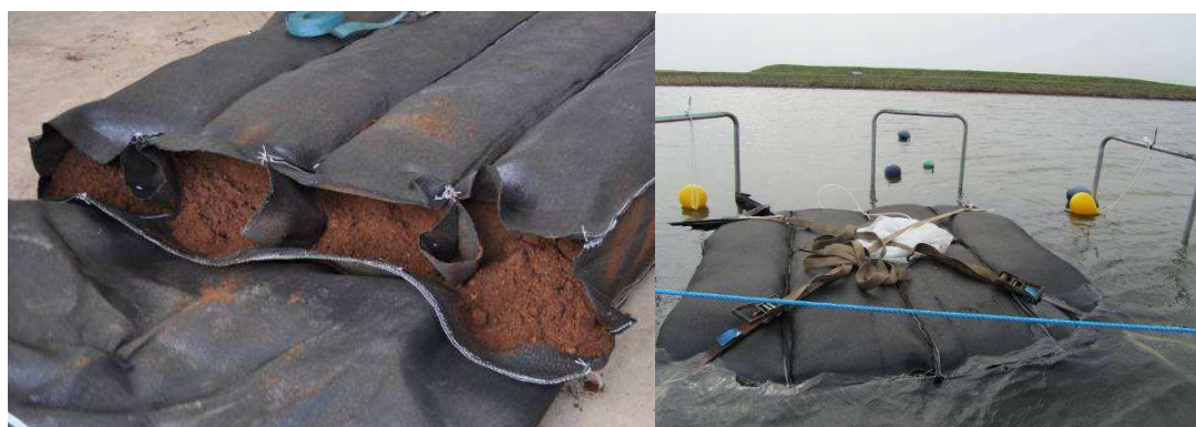
Figuur 3.2 Veenmat, zoals toegepast op de Volgermeerpolder
