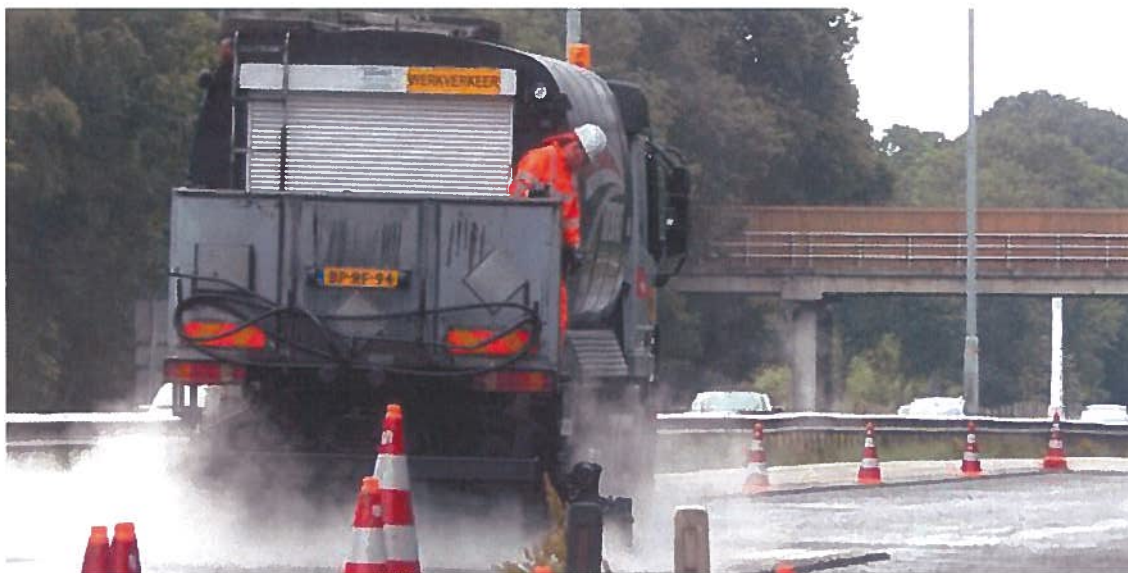
Figuur 9.1 Nieuwe asfaltoverlaging
