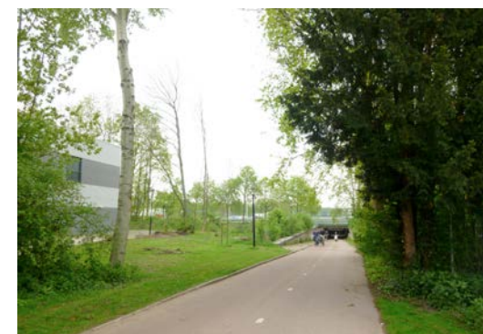
↑ Bestaande fietstunnel onder de A28 door, gezien vanaf het Uppsalapad.
