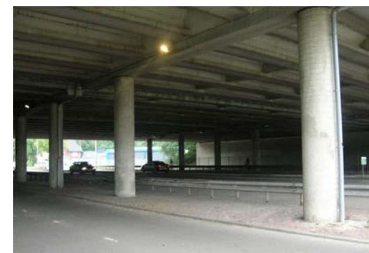
↑ Het plafond van de onderdoorgang Utrechtseweg werkt als klankkast en versterkt het geluid van passerende auto's.
