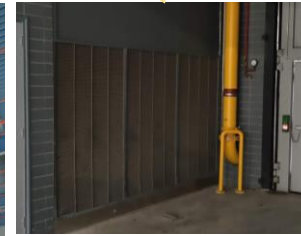
Figuur 3: aanzuigrooster afzuiging
