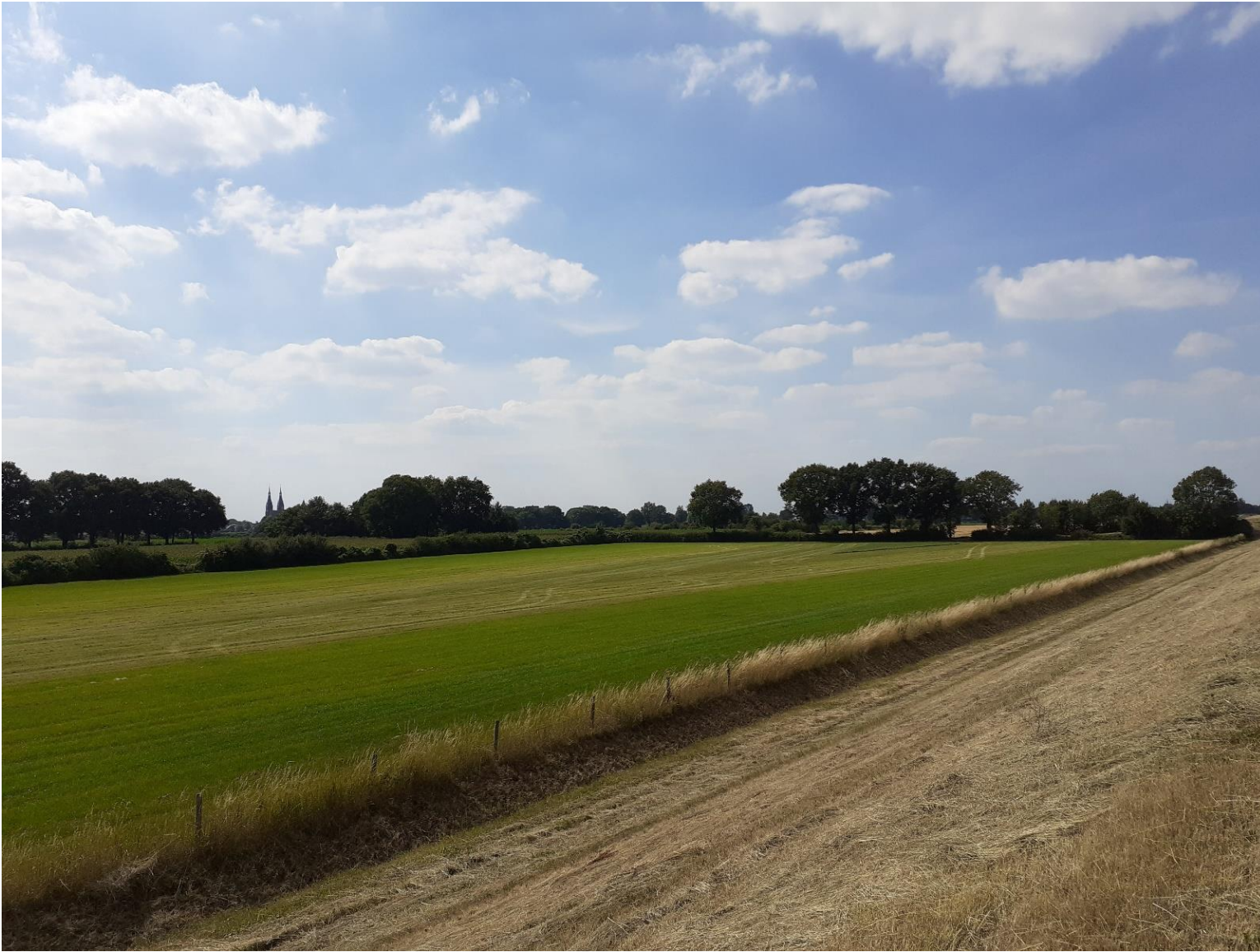
Figuur 22 Afbeelding genomen vanaf de primaire kering ten zuiden van Middelaar, op de achtergrond zijn maasheggen te zien en de kerktorens van Cuijk.
