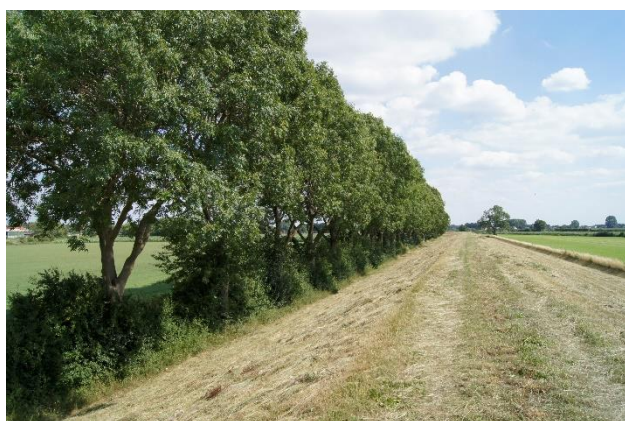
Figuur 34 Bomenrijen langs de dijk tussen Mook en Middelaar
