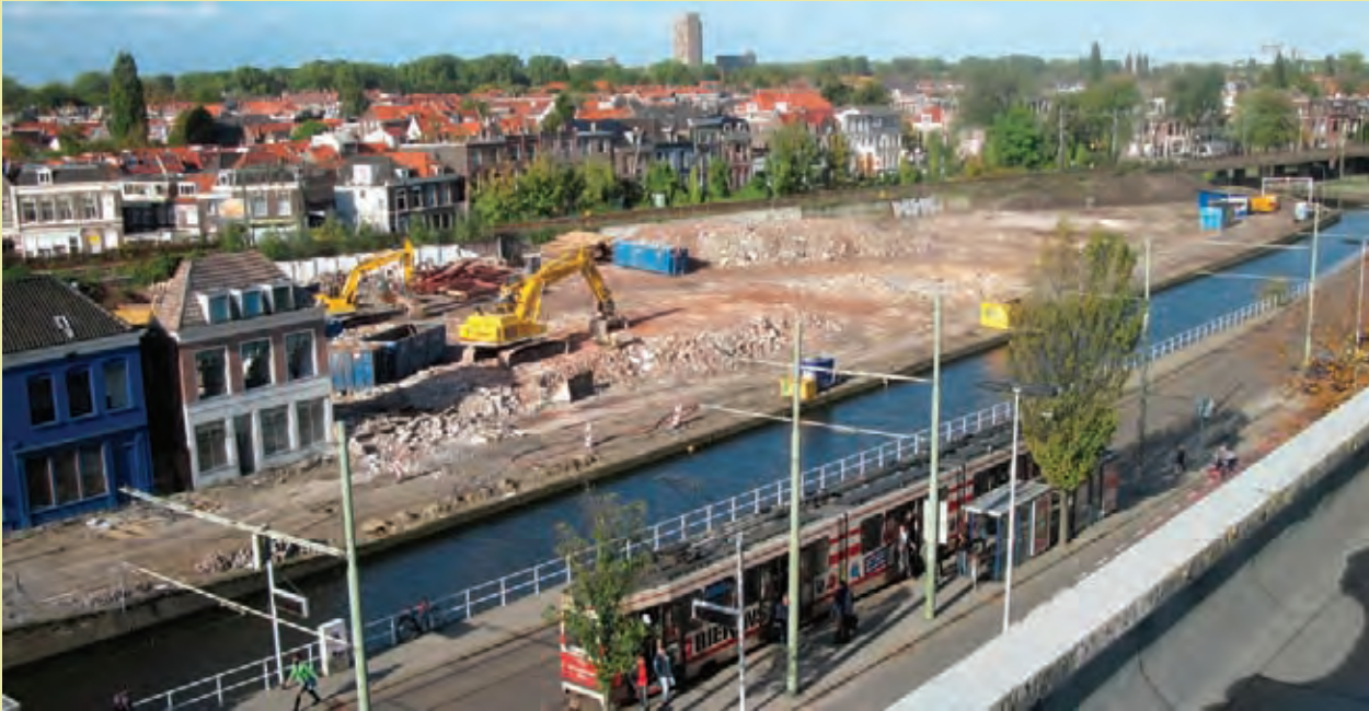
Sanering van het stationsgebied in Delft (foto: Erik van de Giessen)
