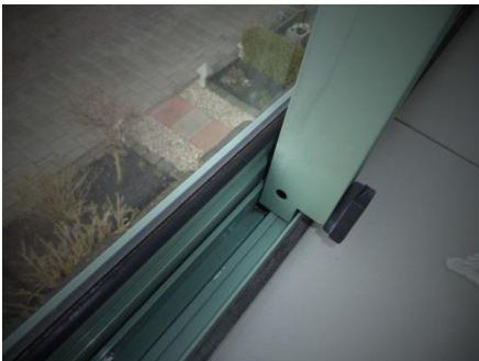
Figuur 27: Enkel glas in stalen kozijnen woning 68
