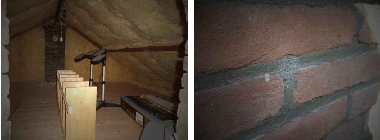
Figuur 40: dakisolatie en boorgaten in gevel woning 107
