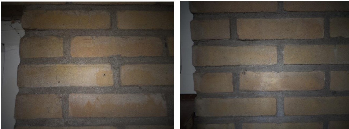
Figuur 23: boorgaten woning 64
