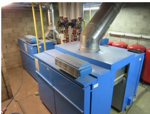
Figuur 52: Collectieve CV-ketel straat x
