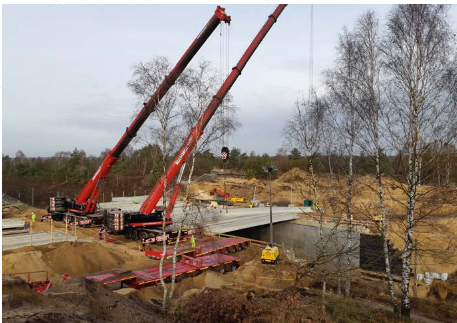
Plaatsen liggers bij natuurbrug Asselsche Heide.
