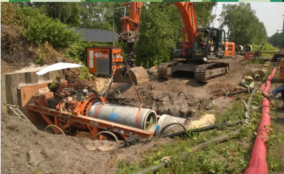
Boren van faunatunnel onder de spoorlijn Utrecht - Arnhem (UT8).
