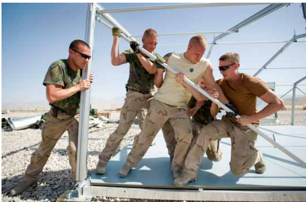
Opbouw tijdelijke infra te Kunduz.
