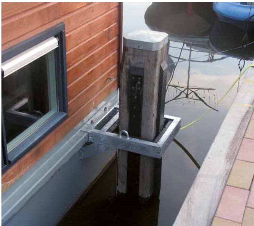
Foto boven: Afmeervoorziening met glijbeugel. Foto: ABC Arkenbouw.
