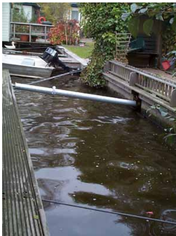
Foto onder: Afmeersysteem met stangen en kabels. Foto: ABC Arkenbouw
