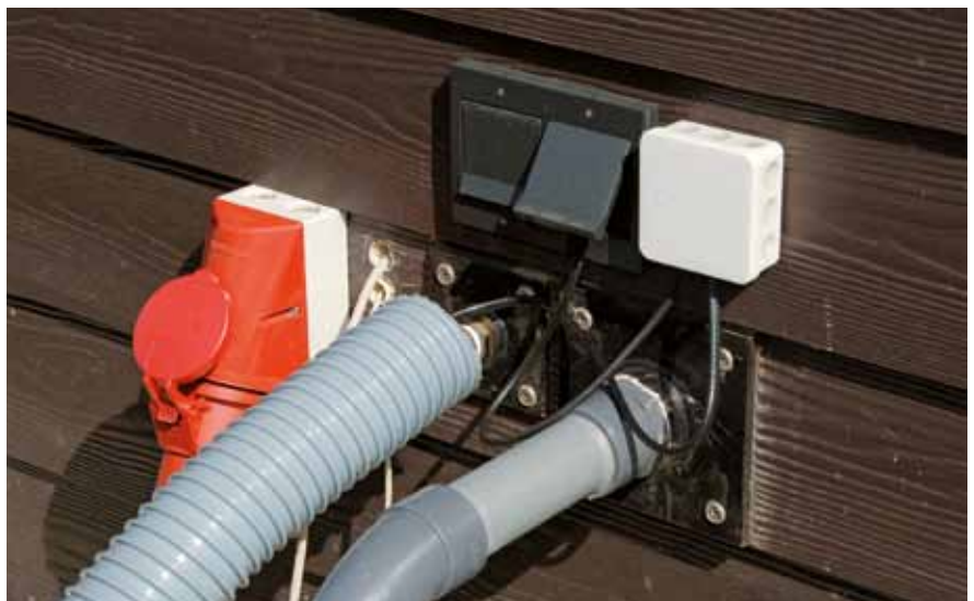
Foto's boven: Nutsaansluitingen drijvende woning. Foto's: ABC Arkenbouw.
