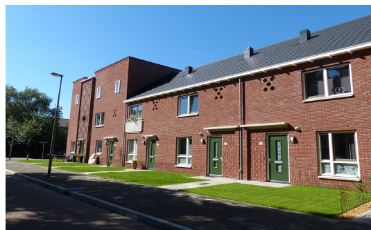
Afbeelding 1: Binnenhofjes fase 2 (Foto: Nijhuis Bouw)
