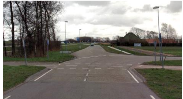
Afbeelding 9: Onveilige T-aansluiting (Cyclomedia, 2021)
