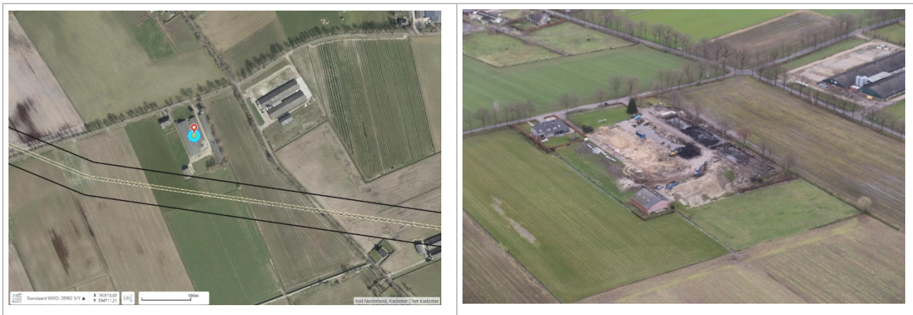
Figuur 18: Links de situatie in gemeente Son en Breugel op de luchtfoto 2020 met panden aanwezig op de rand de SVB-strook. Rechts de situatie in maart 2021 vanuit de lucht waargenomen waarin te zien is dat de betreffende panden gesloopt zijn.
