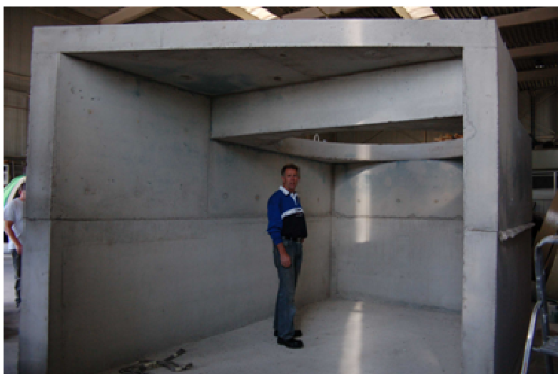
Figuur 6. De uitzwembak. Aan de bovenzijde is het ronde gat te zien waar de buis van de hevelvistrap op wordt aangesloten.
