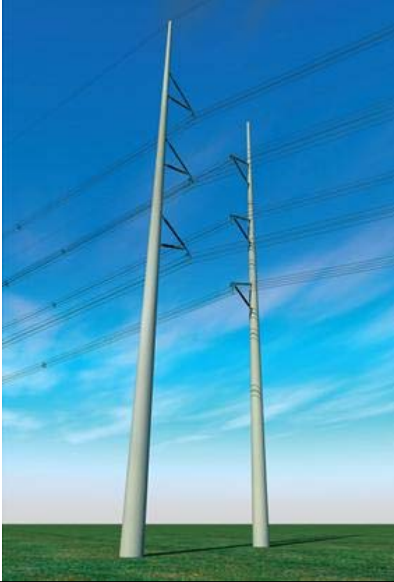
Figuur 3.1 M-compactmast (380 kV dubbelcircuit)
