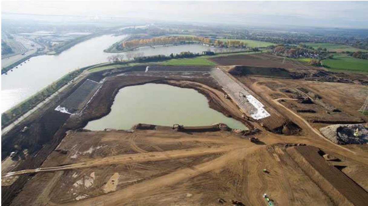
De werkhaven in aanleg in Trierveld.
