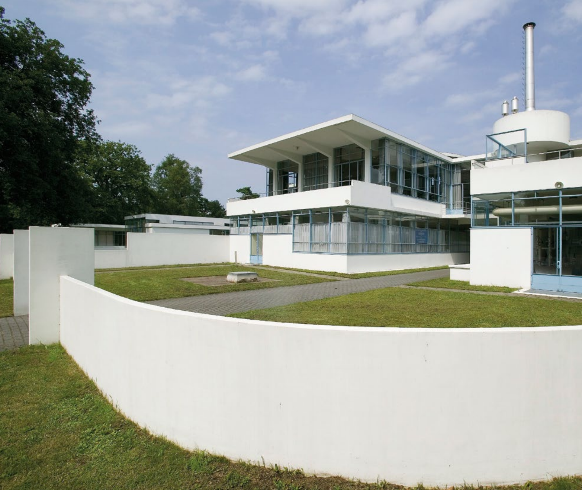
Sanatorium Zonnestraal: het hoofdgebouw
