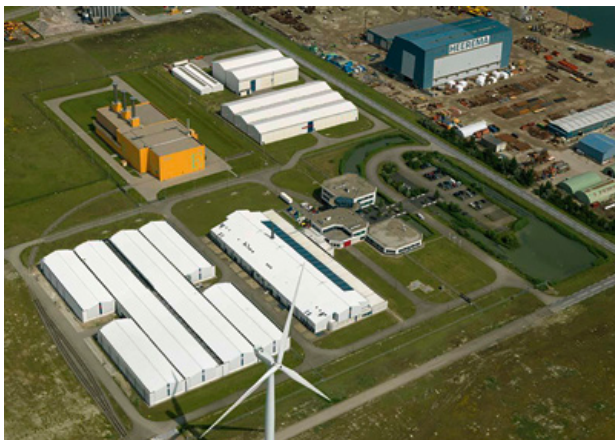
Figuur D.1 Terrein van COVRA (situatie vanaf 2010).
