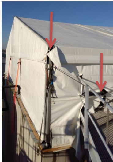
Afbeelding 5.1. Tentconstructie over een AWZI met nog zichtbare openingen.
