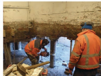
Funderingsherstel, veelvuldig in Nederland toegepast, maar niet tegen trillingen
