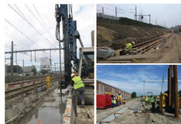
Sloten zijn overal aanwezig, trillingschermen op diverse locaties (beton, jet-grout, damwand, EPS, bekleed beton, o.a. Utrecht, Tricht, Arnhem)
