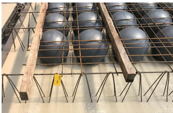
foto 5 Breedplaten met gewichtsbesparende voorzieningen BubbleDeck (links) en U-boot (rechts)
