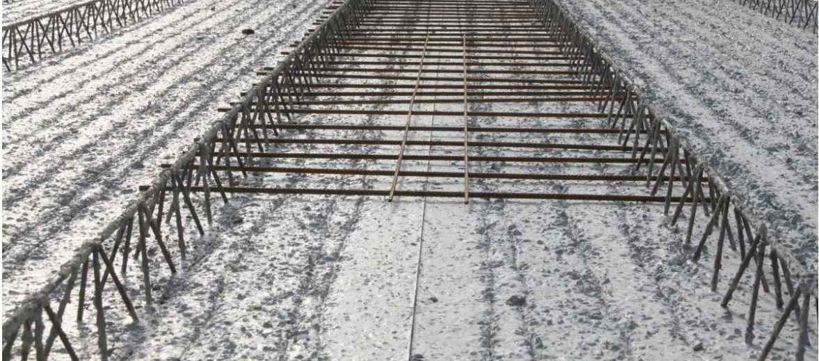
foto 4 Koppelwapening op de breedplaat, bron: https://predalco.be/wapening-betonnetten-predallen/
