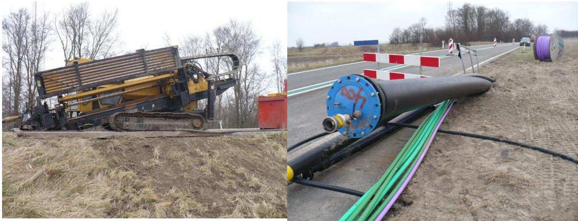
Figuur 14: Foto links boormachine, Foto rechts afgewerkt uittredepunt
