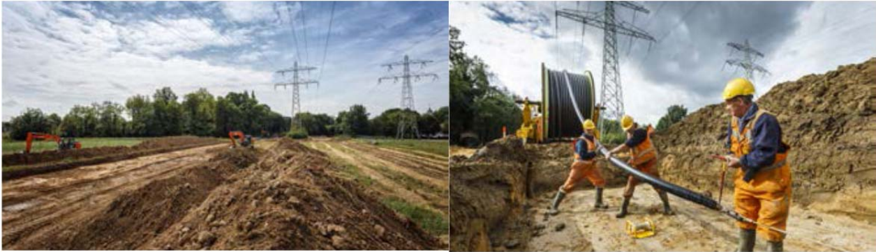
Foto 19: Open ontgraving, sleuven graven en kabels trekken.
