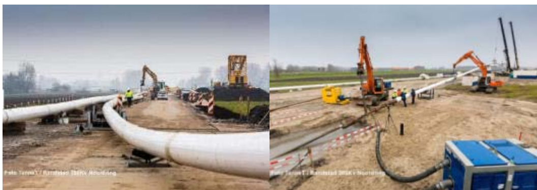
Figuur 17: Boring Randstad 380 kV
