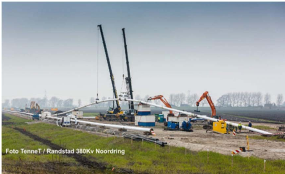
Figuur 16: Boring Randstad 380 kV
