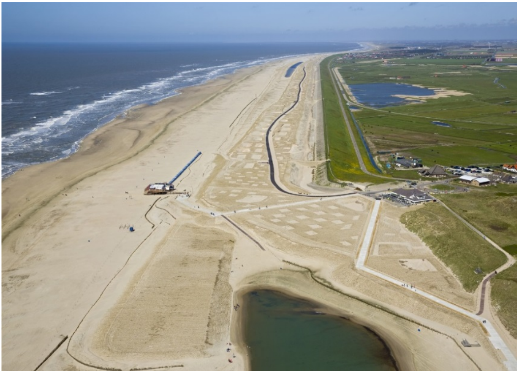
Figuur 4.2 Luchtfoto van de Hondsbossche en Pettemer Zeewering na realisatie
